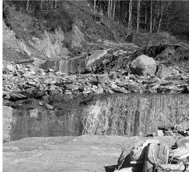
Durch eine Baugrunduntersuchung mit einer Tiefenbohrung bis 28 Meter unter den Baugrund wurde festgestellt, dass das Fundament des Ausleitbauwerk nicht auf gewachsenem Felsen fixiert werden kann. Aufgrund dieser Erkenntnisse musste eine andere Konstruktionsweise gefunden werden, die den hohen Anforderungen dieser Art Wildwasserverbauungen Rechnung tragen kann.
