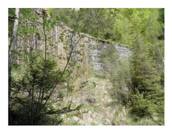
Die Sperren in den Brichen wurden 1912 auf den obersten Malmkalkschichten erstellt. Diese Sperren hatten zum Ziel die Rutschmassen zu stabilisieren. Seit dieser Zeit hat sich der Bewuchs weit in die Schutthalde hinaufgearbeitet und übernimmt heute einen wesentlichen Teil zur Stabilisation des Gehängeschuttes. Die Vermessung der oberen
