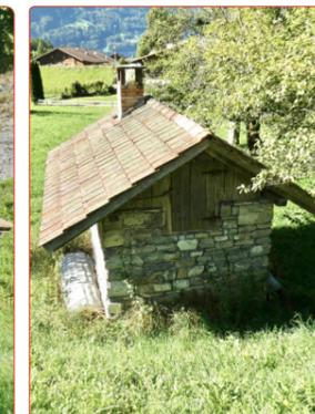
Typischer Schwander Dörröfen von vorne und hinten. Gut erkennbar auf der Rückseite die Türe in den Abdörrraum unter dem Dach.
