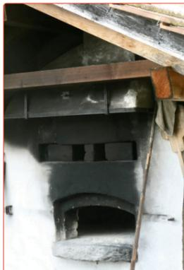
Einschliessloch mit Steinplatte, die verschiebbaren Ziegelsteine und der Rauchfang darüber.
